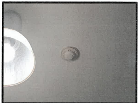
รูปที่ 3.25 เครื่องตรวจจับความร้อน
