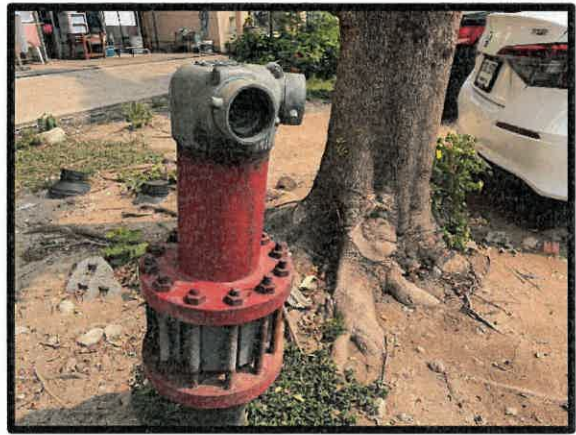
รูปที่ 3.21 หัวรับน้ำดับเพลิงภายนอกอาคาร
