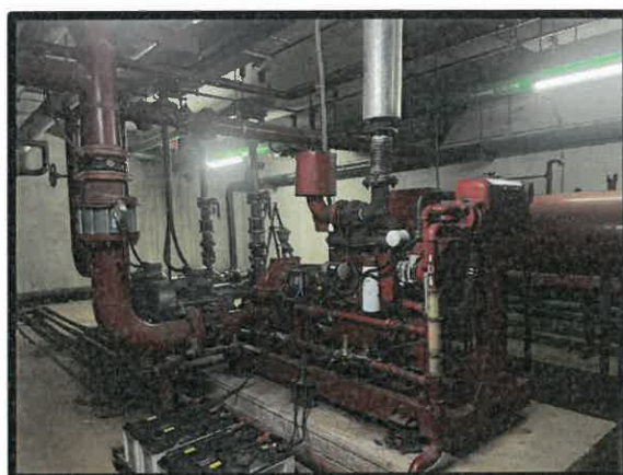
รูปที่ 3.18 เครื่องสูบน้ำดับเพลิง (Fire pump)
